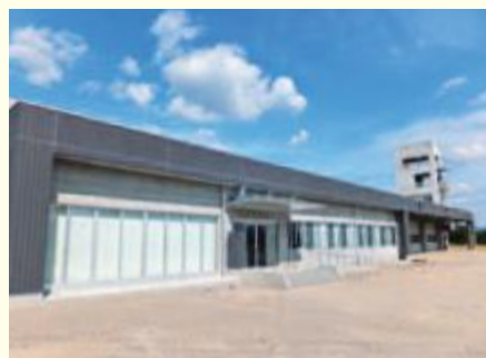
▲今後、外構工事をして開署が待たれる飯坂消防署
