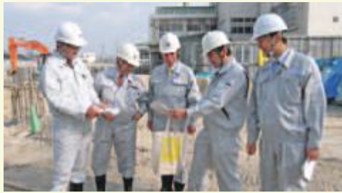
▲野田小学校北校舎建設現場にて進捗状況確認
